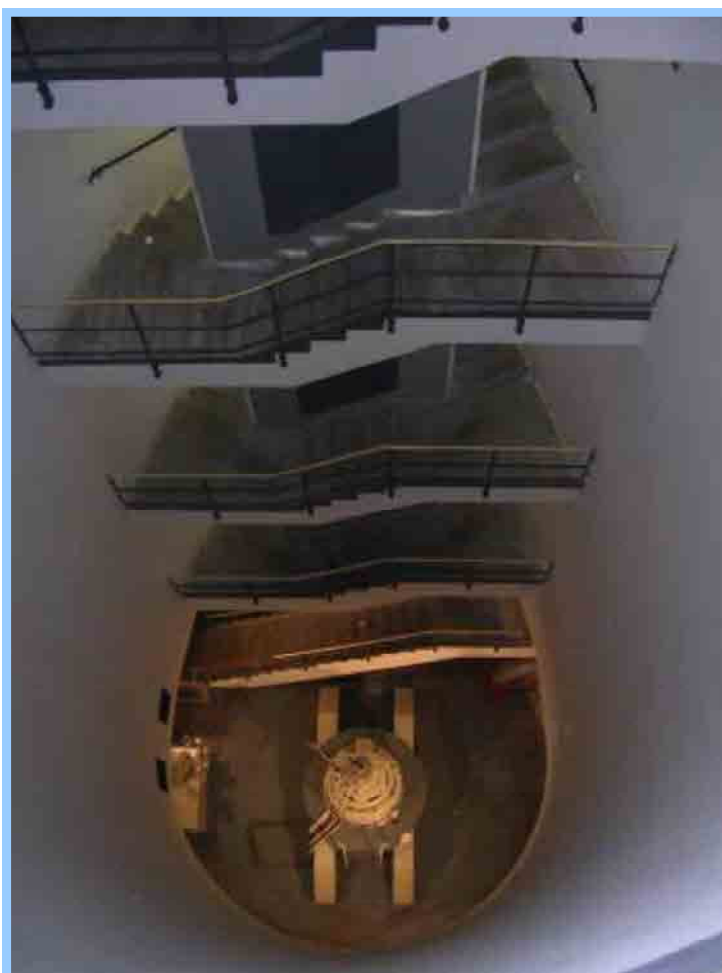
Sopra Diga Val Schener, sotto interni Centrale Val Schener
